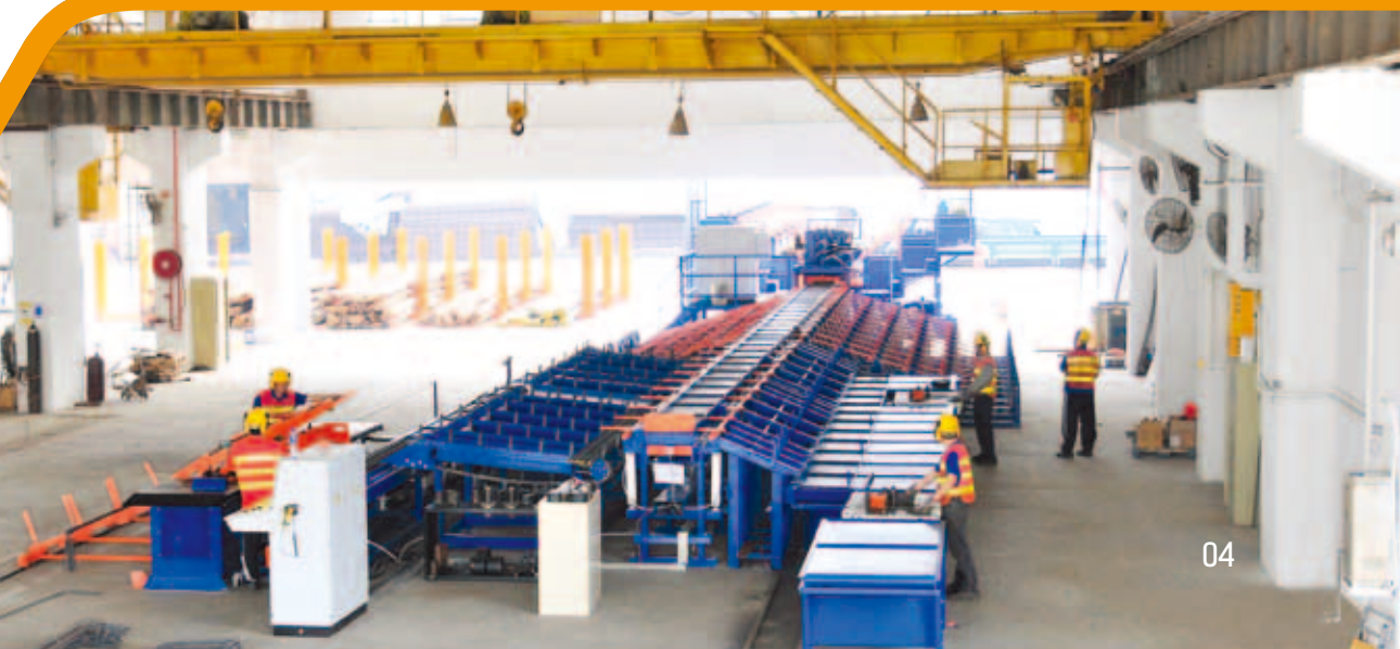
香港大埔之鋼筋增值加工中心
