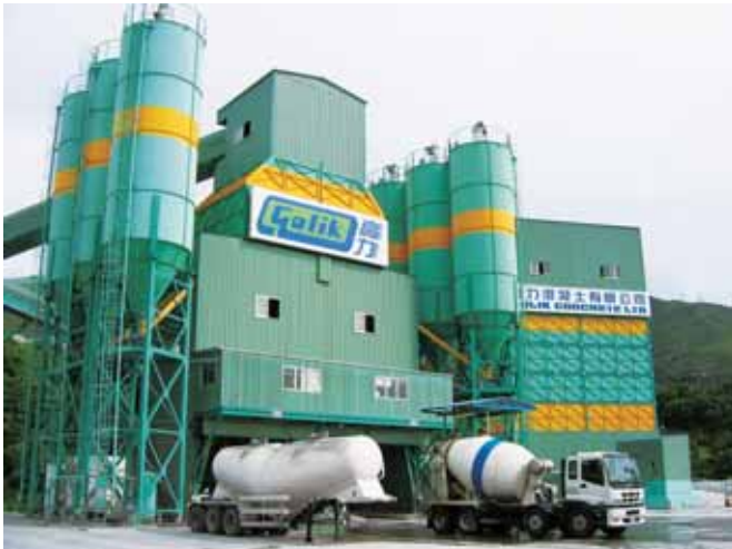
香港大嶼山小蠔灣之混凝土廠
