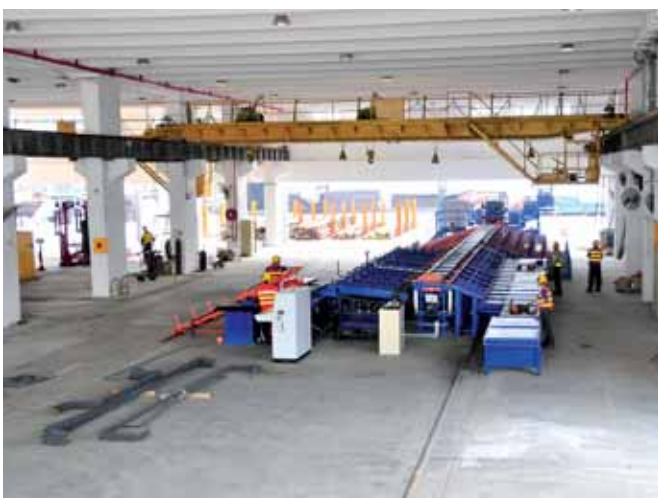
香港大埔之鋼筋加工中心
